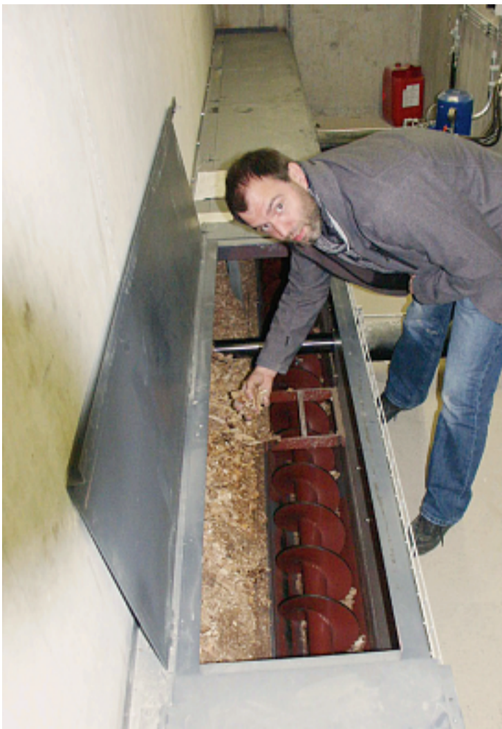
Kilian Grimm hat die Heizanlage konzipiert – der grosse Heizkessel ist gut drei Meter hoch. Der zweite Ofen im Kaskadensystem schaltet zu, wenn der Bedarf an warmem Wasser zunimmt. Eine Schnecke befördert die Schnitzel vom Silo zu den Öfen.
