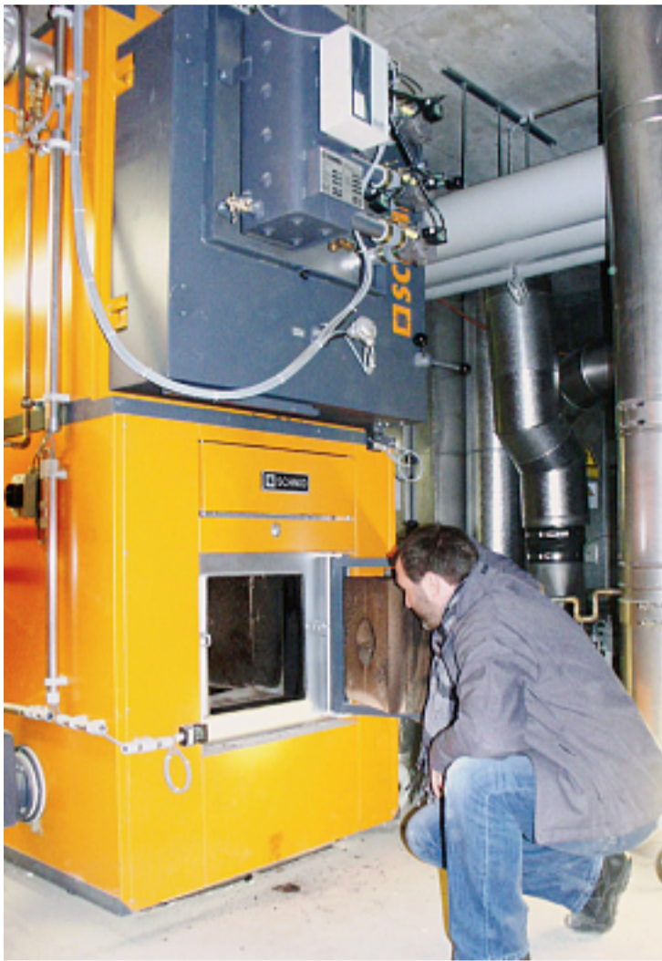
Kilian Grimm hat die Heizanlage konzipiert – der grosse Heizkessel ist gut drei Meter hoch. Der zweite Ofen im Kaskadensystem schaltet zu, wenn der Bedarf an warmem Wasser zunimmt. Eine Schnecke befördert die Schnitzel vom Silo zu den Öfen.
